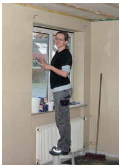
Når frivillige inddrages i arbejdet på KFUMs Soldaterhjem er det vigtigt, at opgaverne er konkrete og til at gå til. Her er Tanja i gang med at spartle.
