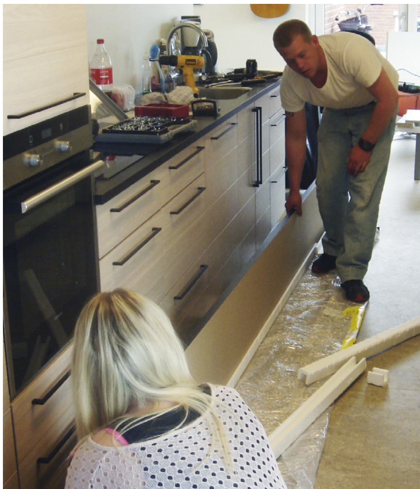
En soldat hjælper soldaterhjemsleder Natalie med at montere et køkkenskab i den nybyggede soldaterrekreation. Efter indflytning viste der sig, at der var behov for yderligere køkkenfaciliteter, hvilket nu er kommet i stand.
